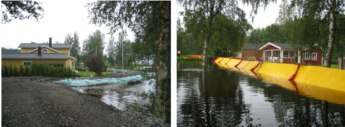
Två olika slags tillfälliga skydd, båda från Vidöstern i Småland 2004. Grusvallen kräver en betydligt mer kostsam återställning efteråt.
